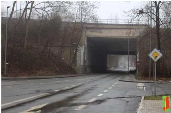
Gleistrasse über den Werner Hellweg unmittelbar vor der A 43 Auffahrt Bochum Laer
