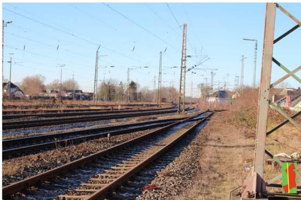
Gleistrasse Höhe Rüsingstraße (Blick nach Westen)
